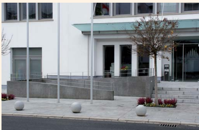
Rollstuhlrampe vor der Gemeindeverwaltung
